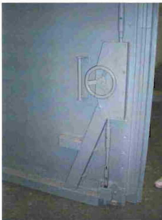
Istniejąca brama pożarowa hali dużej
